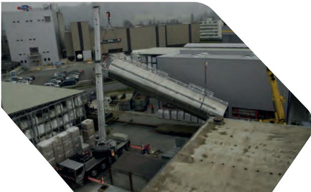
Mit einem jährlichen Produktionsvolumen von 12.000 Tonnen erreicht die GEZOLAN AG Ihre Kapazitätsgrenze. Zudem werden zwei neue Füllstoffsilos errichtet.
